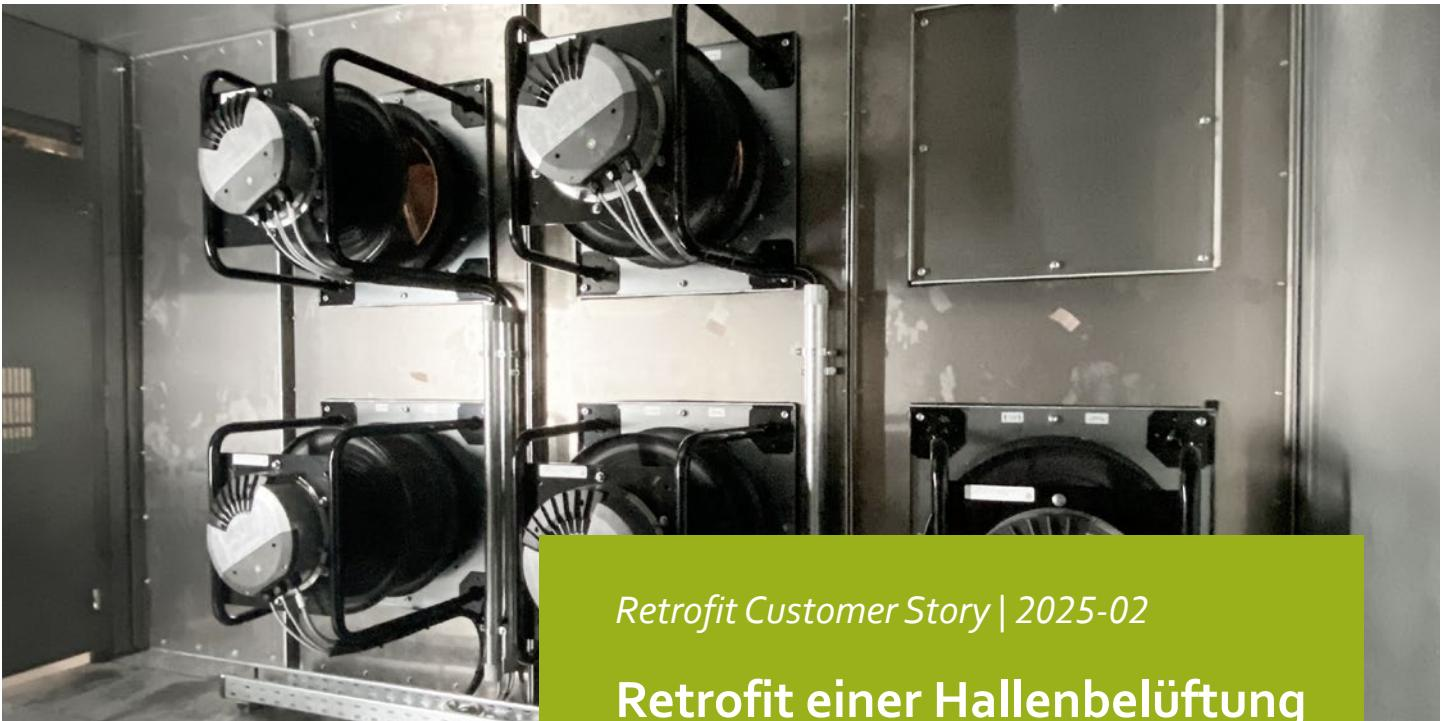
Die fünf RadiPac EC-Ventilatoren sorgen für die nötige Redundanz der Anlage. Das linke Segmentblech kann leicht demontiert werden, was den Zugang auf die Saugseite erleichtert.
