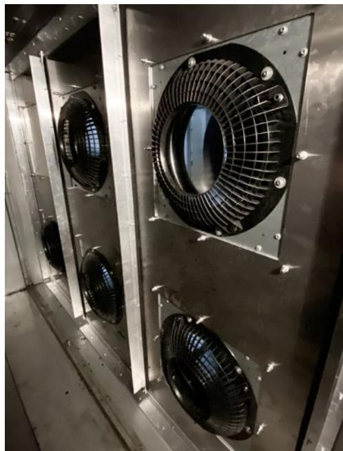
Das FanGrid wurde so ausgelegt, dass sich jederzeit einfach ein weiterer Ventilator einbauen lässt. Die dafür vorgesehene Öffnung ist mit einer Klappe verschlossen.
