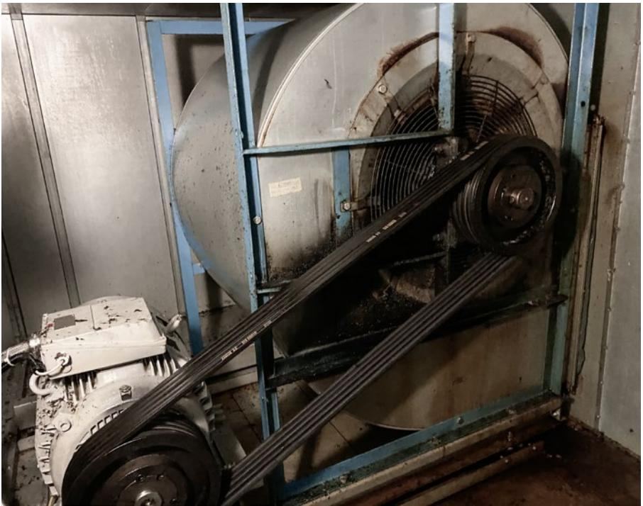
Beim Kunden waren für die Zu- und Abluft IE4-Motoren im Einsatz, die durch den Riemenantrieb und den schlechteren Wirkungsgrad der Ventilatoren viel Potenzial zur Optimierung boten.
